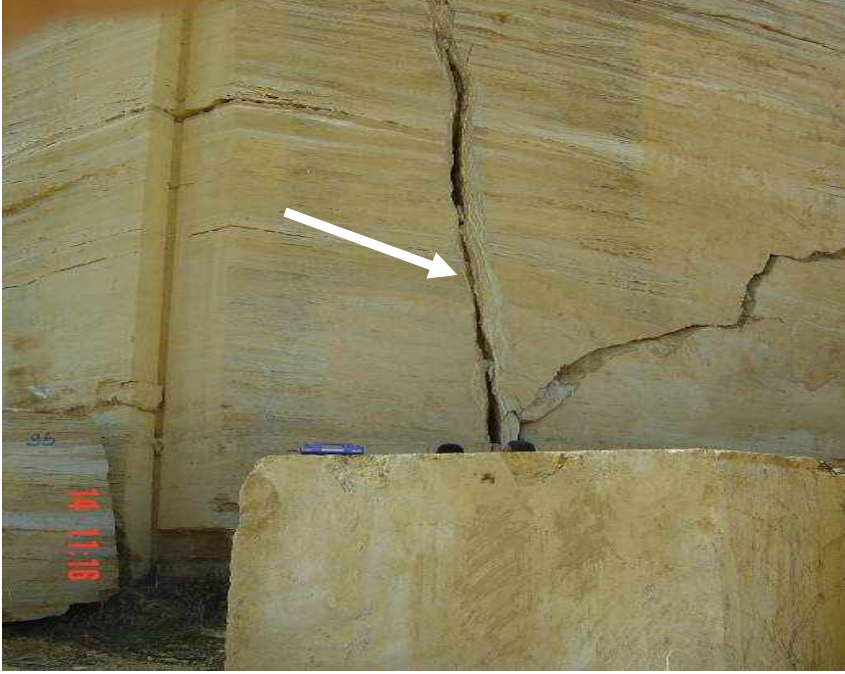
Şekil 4. Sarı travertenlerdeki açılma çatlakları
